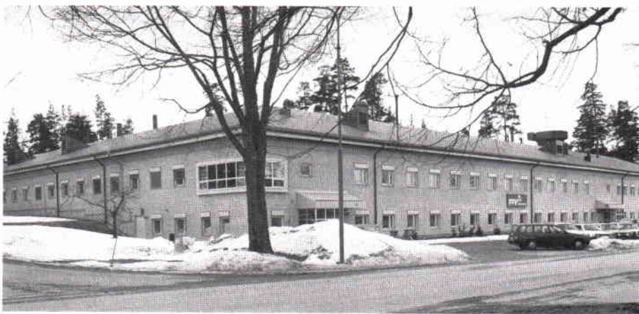
FFV Materialteknik inrymmer bl a i en huvudbyggnad uppförd 1981 och innehåller 150 rum.
