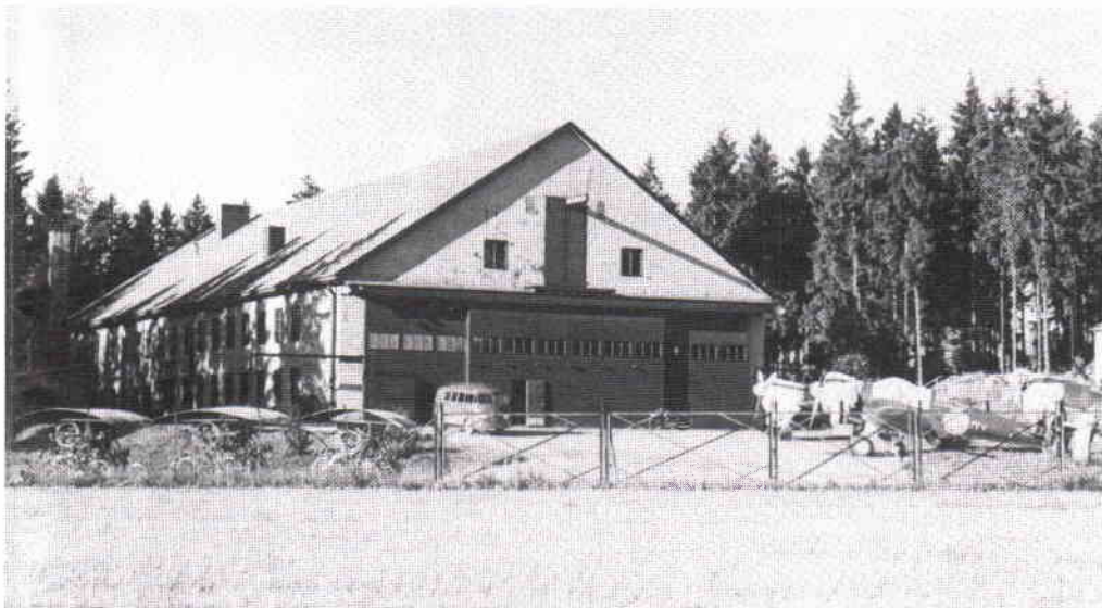
Verkstadsskolan var inrymd i denna byggnad, från början en "beredskapslada", tillhörig CVV och belägen vid Johannisbergs flygfält c:a 5 km söder om Västerås stad.
